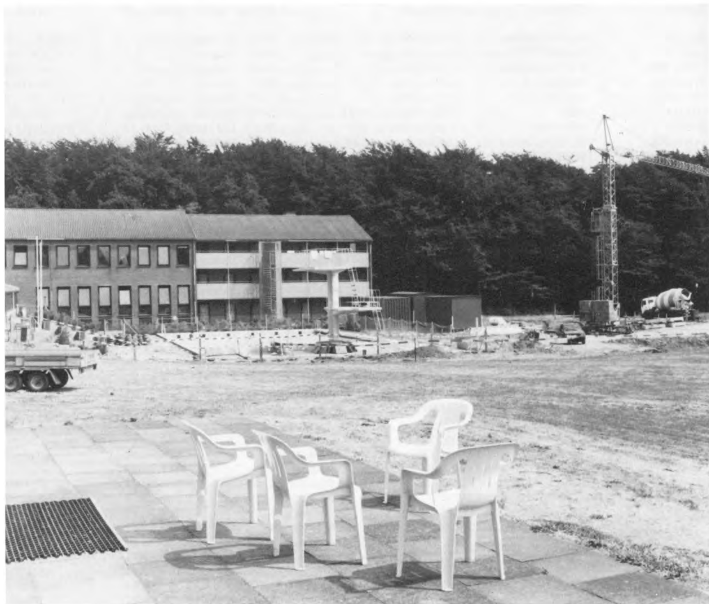
Byggepladsen på DJI 1992 - her skal KUGLEN vokse op.
