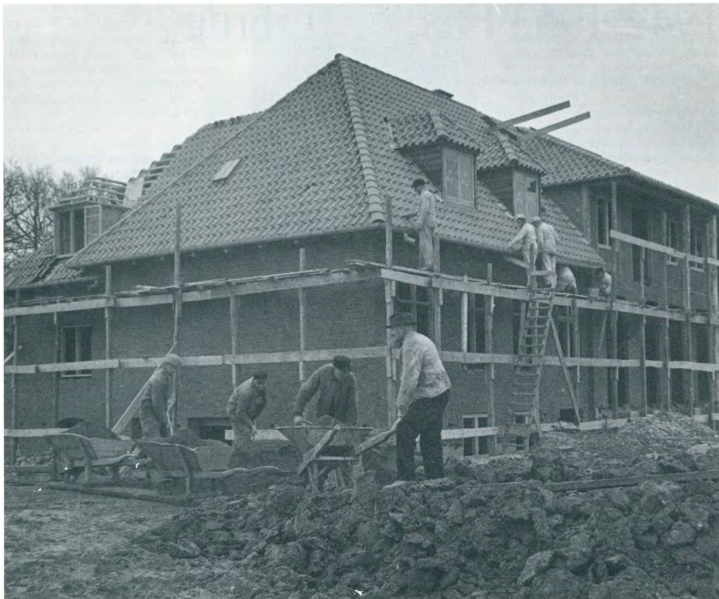
Byggeplads anno 1942, da skolens hovedbygning tog form. I dag ville stilladset's opbygning give røde knopper hos Arbejdstilsynet.
